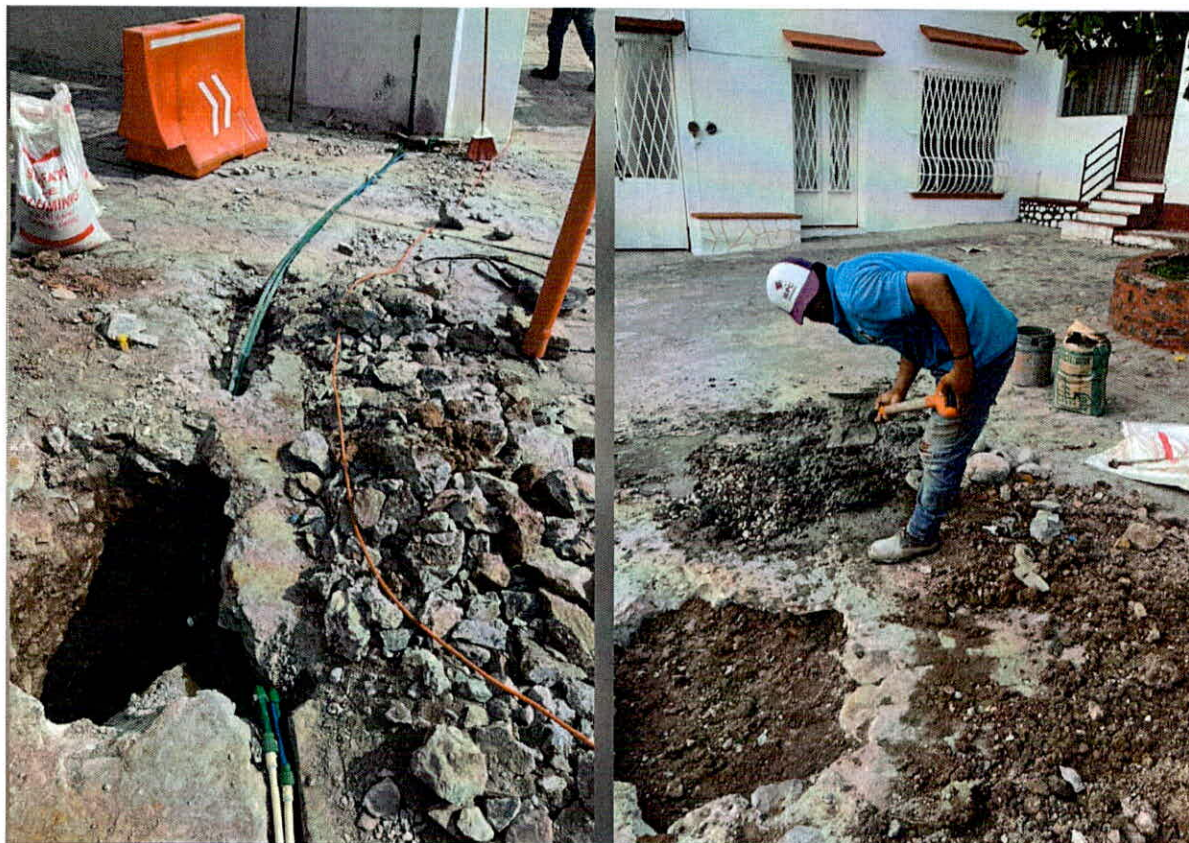
Ilustración 15 reparación en la red de distribución
