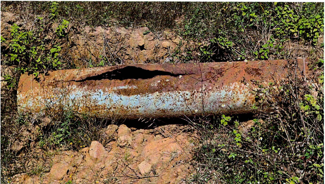
Ilustración 12 tubería de metal de 12"(segmento cambiado en la primer etapa)
