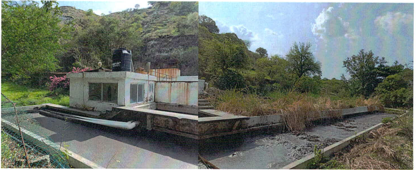
Ilustración 19. Planta tratadora de aguas residuales "Cantarranas"
