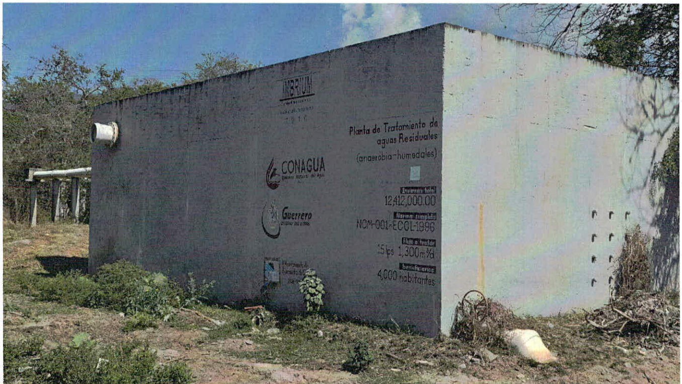
Ilustración 20 tanque de pretratamiento de la PTAR El Rastro.
