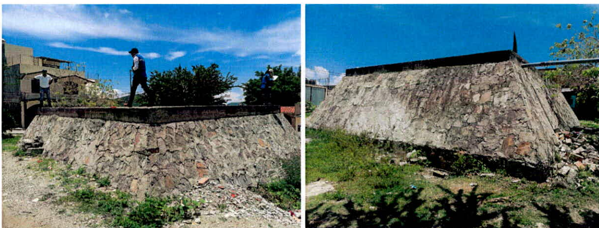
Ilustración 14.- Tanque Santa María (Piedra).
