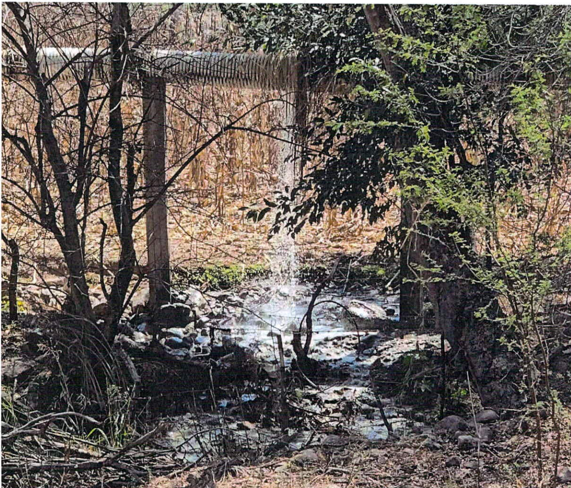
Ilustración 17 Fuga en colector general en dirección a la PTAR EL Rastro .
